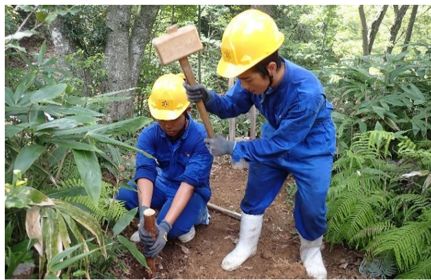
散策道の階段を作製しています。
